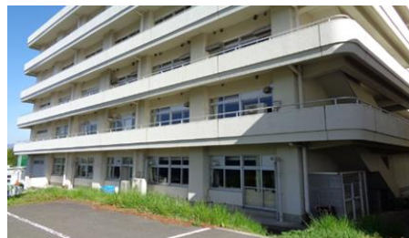
図1 本校2号館南側
